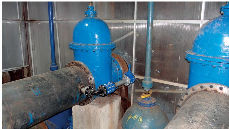
las 5 líneas de tuberías DN700 y el cambio de 2 válvulas de compuertas con obras de soporte y regulación.
