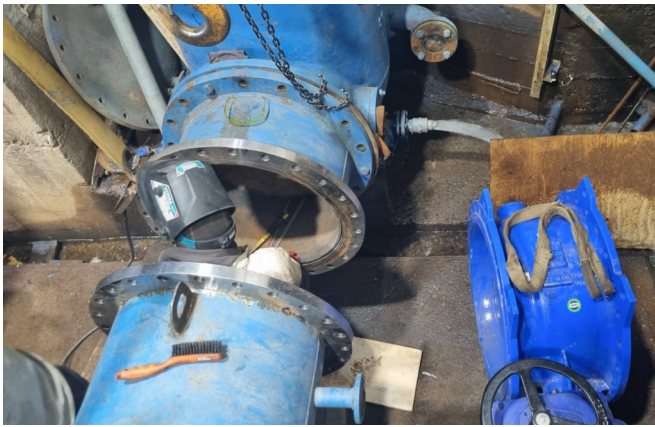
Cambio de válvulas frontales, líneas 1-3 y 5.
