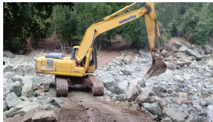
Arreglos en camino de conexión con Sala de Válvulas.
