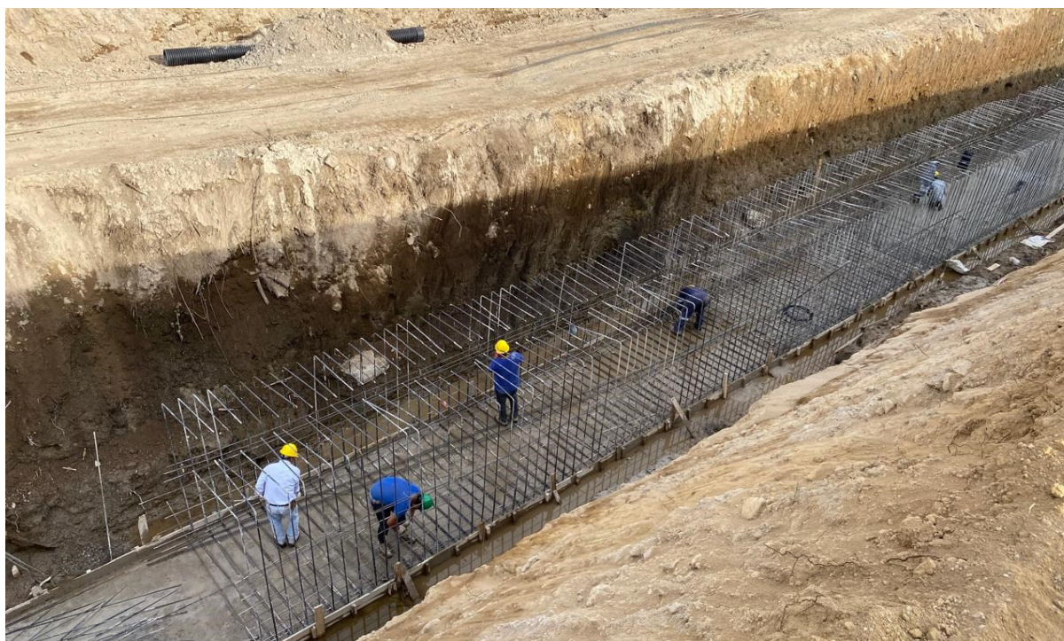
Abovedamiento en canal Nogales—Molino, comuna de Retiro.
