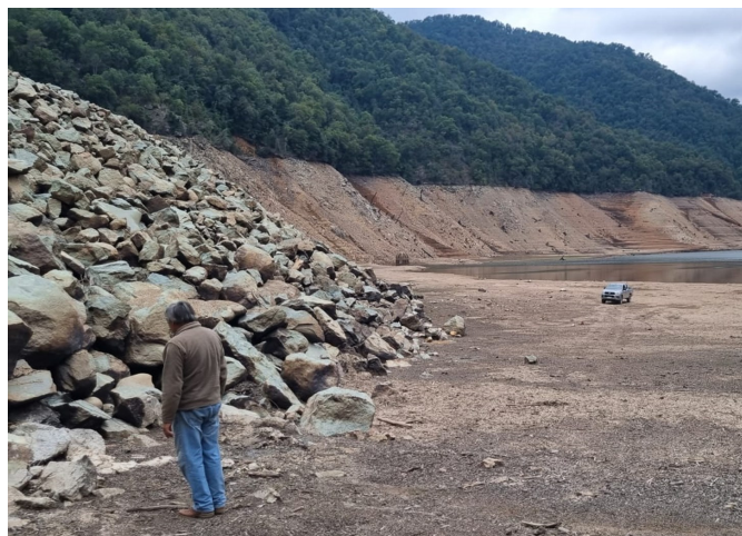
Recambio de Válvulas y mejoramientos en piso del Embalse Bullileo.
