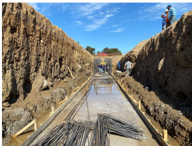
Trabajos al interior del canal que comunica el Río Longaví con el canal Nogales y Molino.
