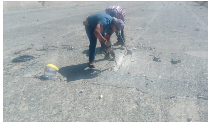
Trabajos en vertedero; 2ª etapa, donde se preparan los puntos a tratar con hormigón.
