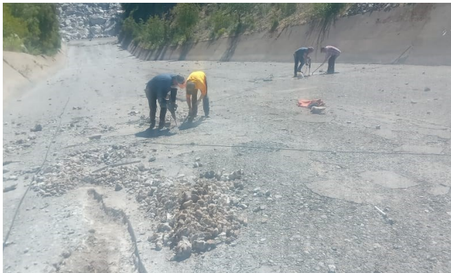
Trabajos en vertedero; 2ª etapa, donde se preparan los puntos a tratar con hormigón.
