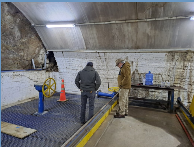
Presidente del Directorio de la JVRL, Máximo Correa, visita avance de trabajo en Sala de Válvulas.
