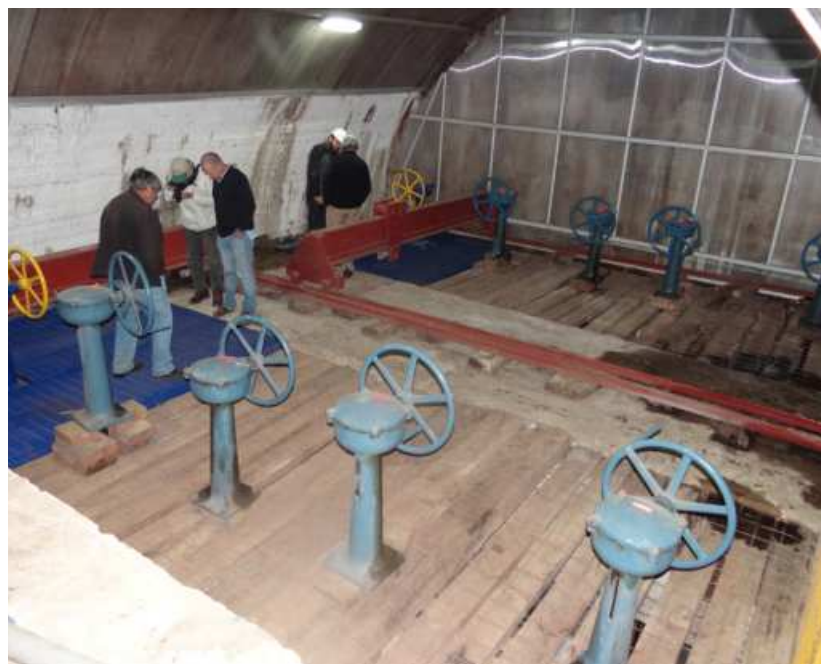
Sala de válvulas en el inicio de los trabajos de mejoramiento.
