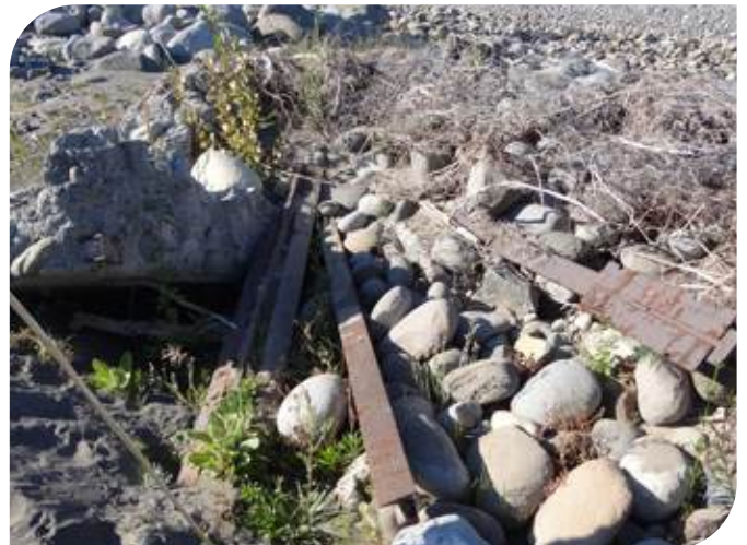
Antigua compuerta de Canal Las Mercedes-Longaví.
