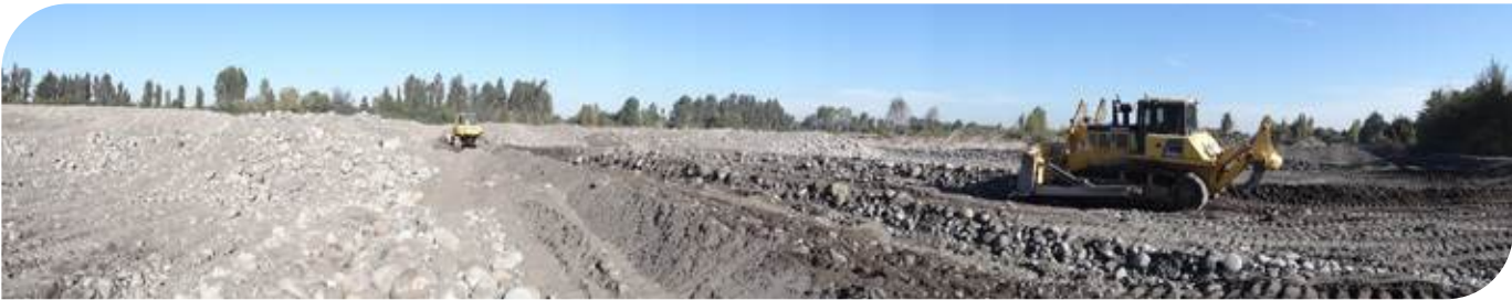
Encausando el río en bocatoma canal Retiro.
