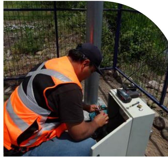
Instalación de red de telemetría.
