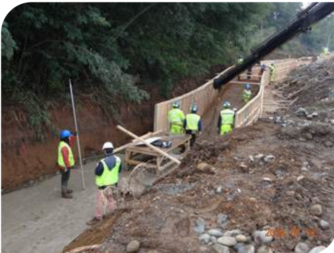
Revestimiento en Remulcao Sur.
