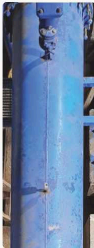
Montaje y pruebas de las válvulas del Embalse Bullileo. La obra cerró una década de trabajo enfocada en la consolidación estructural de la infraestructura matriz.
